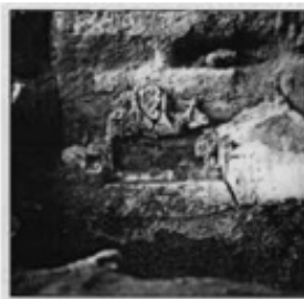
پایه ۸ گوش آجری در دل پایه مستطیل شکل جهت قبله
