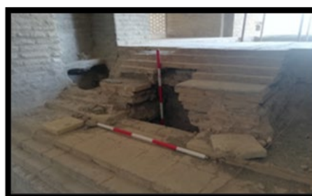
تصویر ۱۳: قسمت PP روی نقشه ۳ و محل قرارگیری احتمالی پمپ پیستونی طبقه دوم (نگارندگان، بهار ۱۳۹۹)
