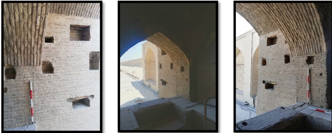
تصویر ۵: محل اتصالات چرخ بر دیواره‌های برج آب در طبقه اول (نگارندگان، بهار ۱۳۹۹)
