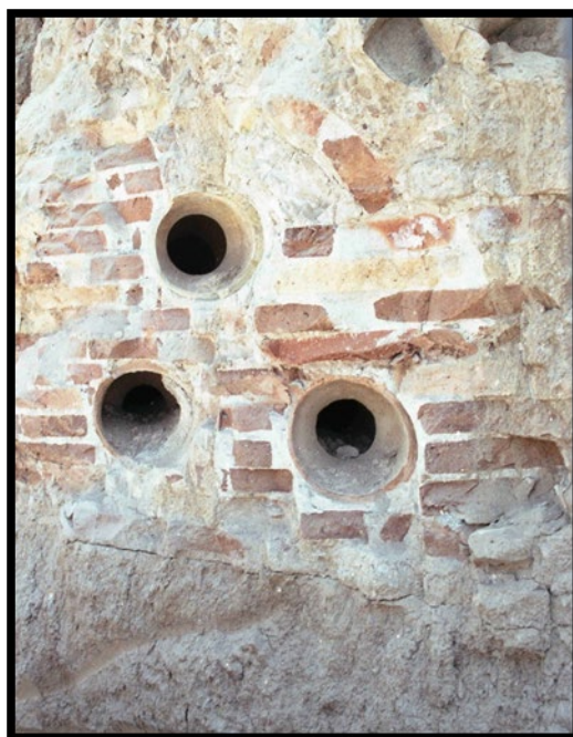
تصویر ۲: تنبوشه‌های یافت شده در جریان احداث ساخت بخش‌هایی از ساختمان استانداری (آرشیو شخصی مرحوم مرتضی پور موسی دهه هفتاد شمسی)
