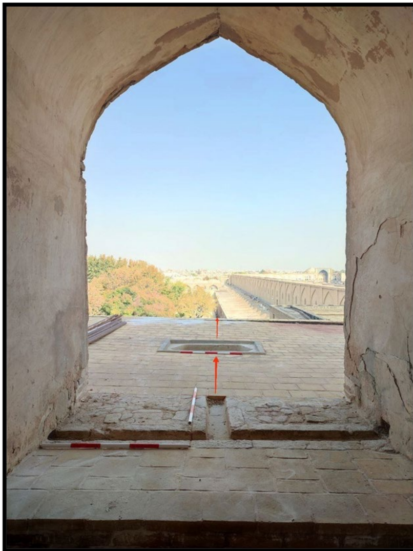
تصویر ۹: آبراهه سنگی و مسیر ورودی و خروجی آب به حوض P2 در طبقه دوم (نگارندگان، پاییز ۱۴۰۲)
