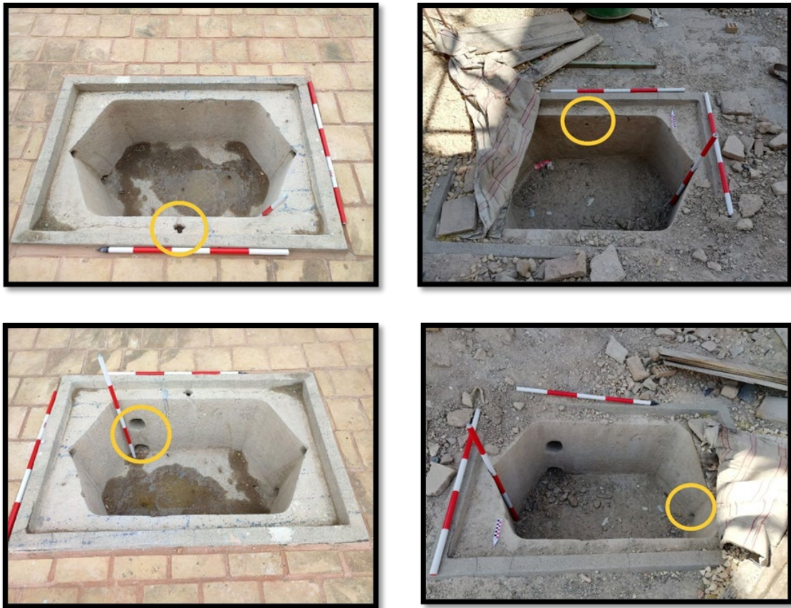
تصویر ۱۰: حوض طبقه دوم (P2) و دریچه خروج اضطراری حوض P2 (تصویر بالا راست)، محل دریچه ورودی آب (تصویر بالا چپ)، دریچه تخلیه حوض (تصویر پایین راست) و دریچه‌های هدایت آب به حوض طبقه سوم و حوض تالار (P3 و P4) (تصویر پایین چپ) (نگارندگان، بهار ۱۳۹۹، پاییز ۱۴۰۲) Figure 10: Second floor pool (P2) and P2 Pool emergency exit valve (Top right image), water inlet valve (Top left image), pool drain valve (Bottom right image) and valves directing water to the third floor and Hall (P3, P4) (Authors 2020, 2023)
