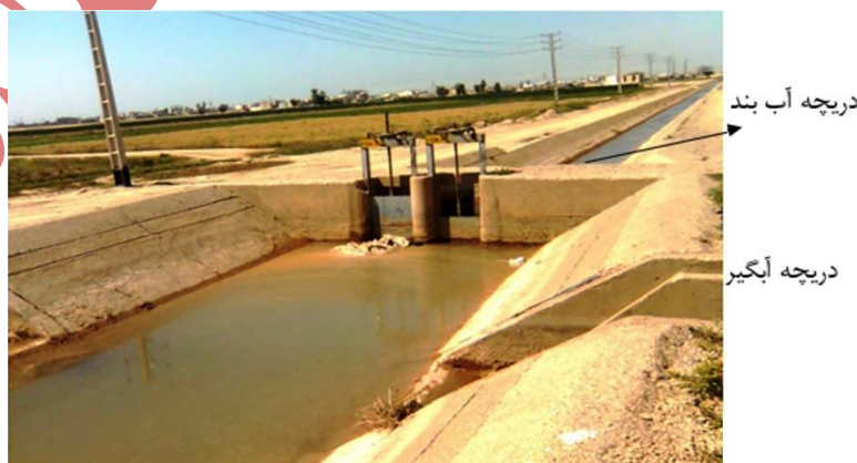
شکل ۲. نمایی از کانال EIR1 و سازه‌های آب‌بند و آبیگر موجود در آن
