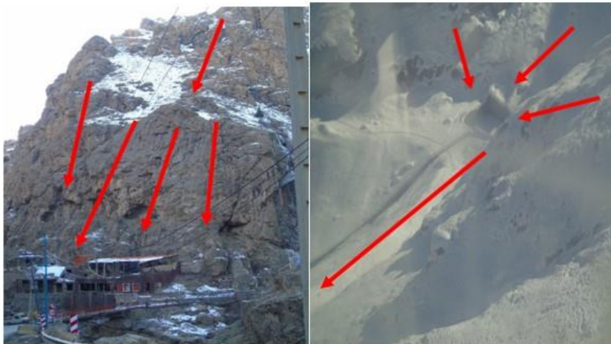
شکل ۷. تصویر سمت راست محلی در پیست اسکی که در سال‌های گذشته بهمن‌های خطرناکی داشته و ساکنین و مسئولین پیست مجبور به حفر خندق و سپس کانالی در مقابل بهمن شدند تا از میزان قدرت و تخریب آن بکاهند. تصویر چپ یک رستوران کوچک محلی که در اثر سقوط بهمن تخریب گردیده است.
