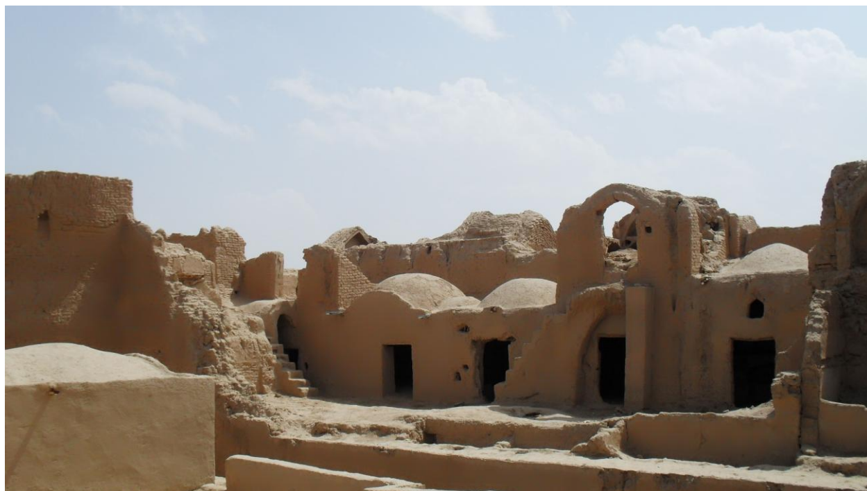
تصویر ۱۶) نمای ساختمانهای دو- و سه‌طبقه قلعه سریزد از بام طبقه اول (عکس از پرتو اخوان)
