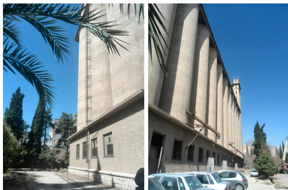
تصویر ۲- سمت راست: نمای شرقی سیلو، سمت چپ: نمای جنوبی سیلو.
