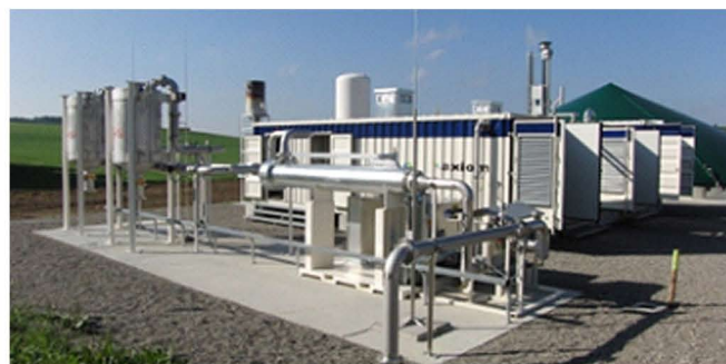
نیروگاه ارتقا بیوگاز به روش جداسازی غشایی در کیسلگ آلمان با ظرفیت ۵۰۰ m 3 /h
