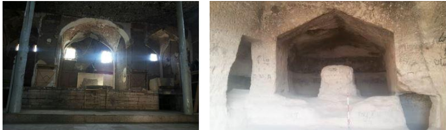
شکل ۵. (راست) مصطبه سازی، سکوی نیایش و پوشش جناغی مجموعه صخره‌ای رصدخانه؛ (چپ) مصطبه‌سازی، سکوی نیایش و پوشش جناغی کلیسای هوانس مراغه
