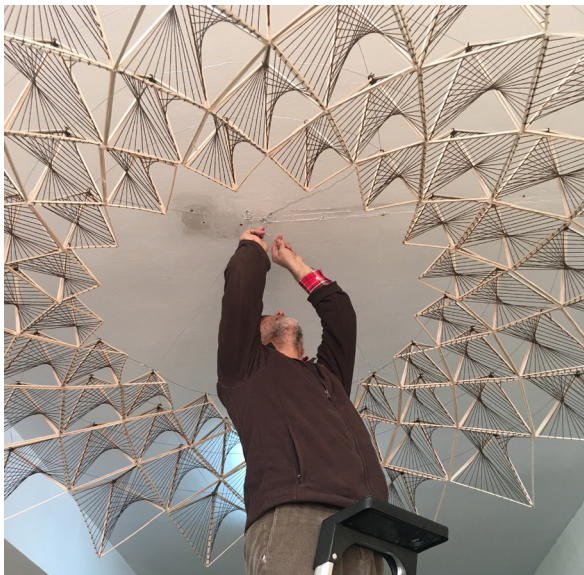
تصویر ۸- نصب پوسته دوم در زیر سقف منتهی به کارگاه.
