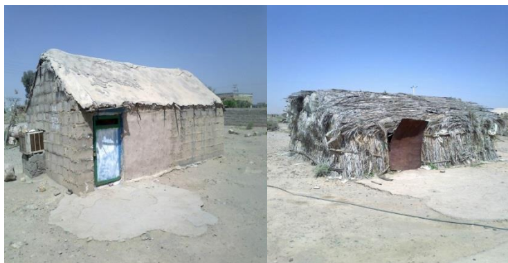
تصویر ۱۳) کپر (کنتوک چوبی)، روستای زاخت: ۱۳۹۴؛ کپر (کنتوک خشتی)، روستای کوشک و مور: ۱۳۹۴
