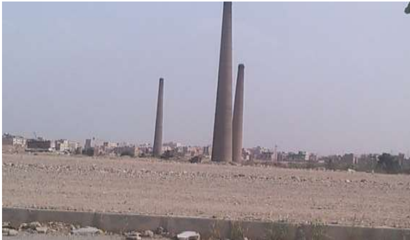
تصویر ۱: کوره‌ها در کنار ساختمان‌های مسکونی
