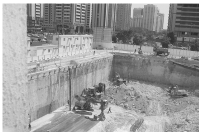
تصویر ۳- پایدار سازی جداره گودبرداری از داخل و خارج گود- روش دیافراگم و دیافراگم و انکراژ. (مأخذ: نگارنده)
