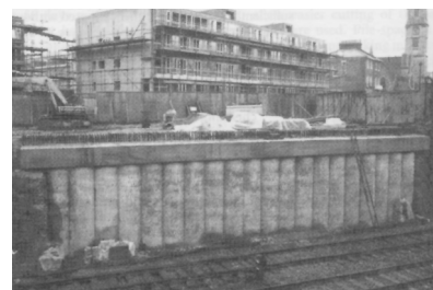
تصویر ۴- پایدار سازی دیواره گودبرداری از داخل - روش اجرای شمع در جا. (Puller, 2005.) (مأخذ: نگارنده)
