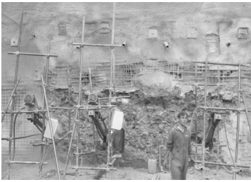
تصویر ۱۲- روش میخ کوبی - حفاری نیل ها. (مأخذ: نگارنده)
