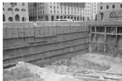
تصویر ۷- پایدار سازی جداره گودبرداری از خارج گود- روش میخ کوبی. (مأخذ: نگارنده)
