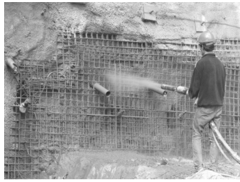
تصویر ۱۳- روش میخ کوبی - شاتکریت. (مأخذ: نگارنده)
