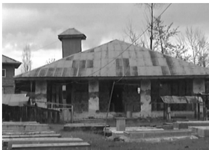
تصویر ۱- بنای ساختمان بیرونی بقعه آقا سید محمد یمنی لیچا، به سمت جنوب، لشت نشاء. ماخذ: (آرشیو شخصی نگارنده)
