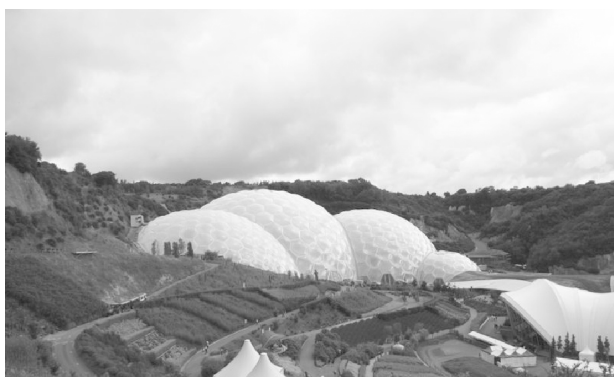
تصویر ۲- تاثیر شرایط محل احداث ساختمان بر فرم سازه‌ای، پروژه باغ بهشت، انگلستان.
