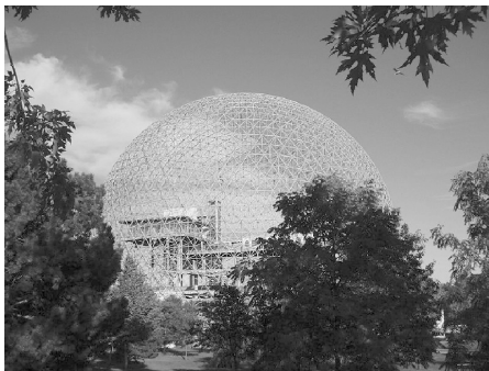
تصویر ۱۴- استفاده از سازه فضاکار به تصویرگنبد ژنودنیک برای عملکرد نمایشگاهی، غرفه آمریکا، اکسپو ۱۸۶۷، کانادا. ماخذ: (www.architecture.uwaterloo.ca)
