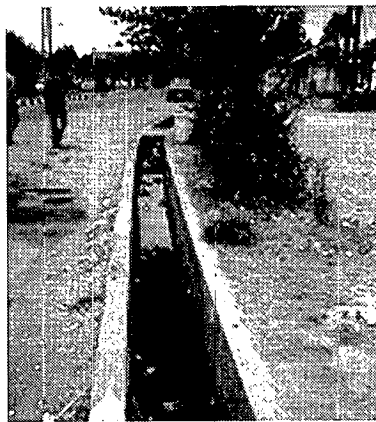
تصویر شماره ۴ یک نمونه از احداث جوی کناره خیابان (روستای نصیر محله، شفت)
