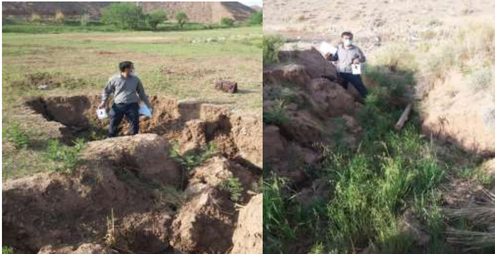
شکل ۲. نمایی از خندق های مشاهده شده
